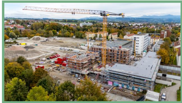
Abbildung 8: Baustelle Parkstadt Engelhalde
